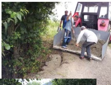
Oprava mostíka u Hraškov
